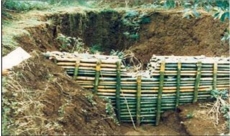
Gambar 6. Bangunan penahan longsor dari anyaman bambu untuk menahan longsor kategori kecil
