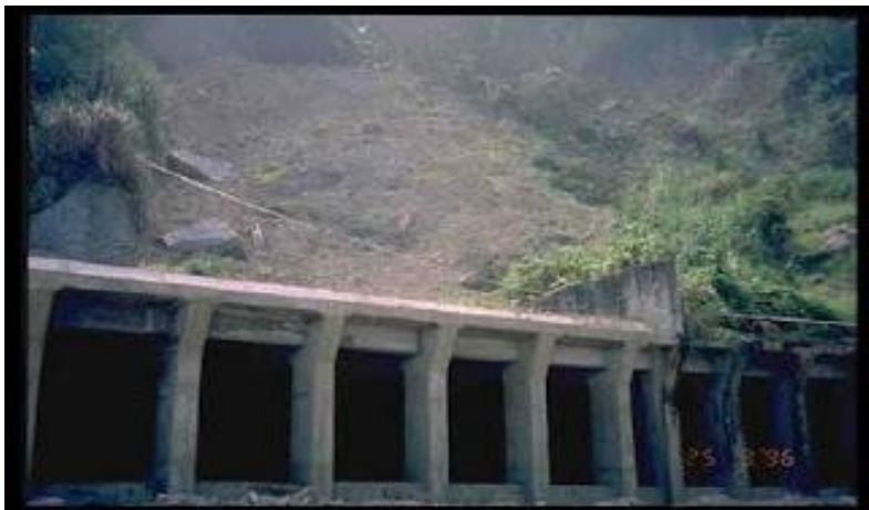
Bambar 7. Bangunan konstruksi beton penahan longsor kategori besar ( Foto: F. Agus dan Widianto)
