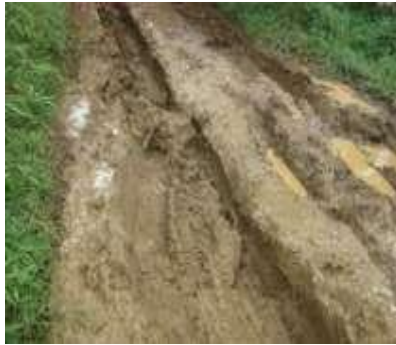
Gambar 18 .Kondisi jalan angkutan kayu dan Kedalaman tanah bantu terbentuk tanpa alat bantu
